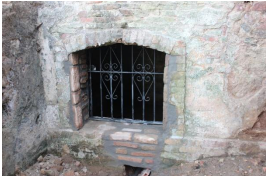
33. Colocación de la reja en el acceso
