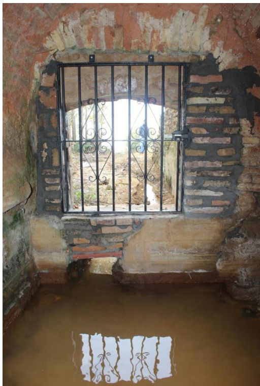
35. Aspecto de la reja desde el interior de la caja de agua.
