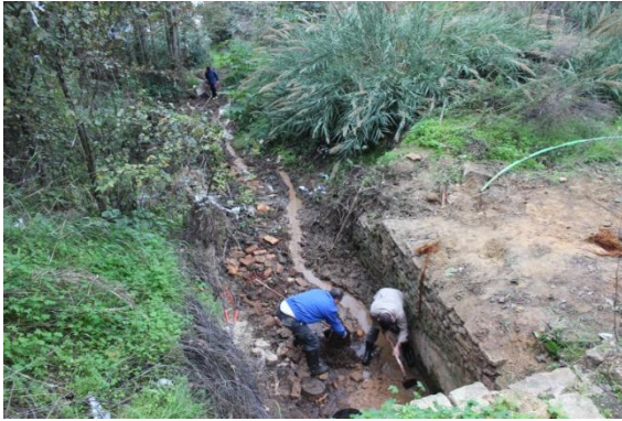
25. Primeros trabajos de limpieza en Fuente Vieja con el voluntariado
