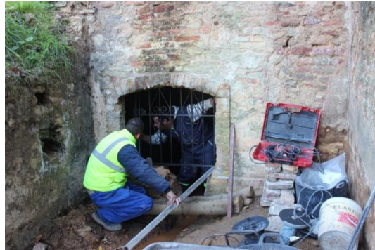
32. Colocación de la reja en el acceso
