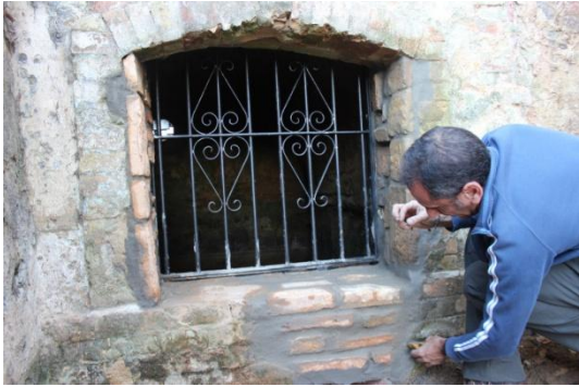
31. Colocación de la reja en el acceso
