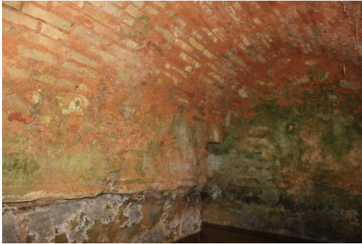
90. Interior de la caja de agua
