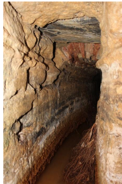
30. Interior de la galería Sur
