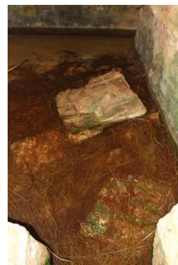
24. Aspecto inicial del interior de la caja de agua
