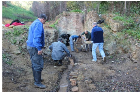
28. Primeros trabajos de limpieza en Fuente Vieja con el voluntariado
