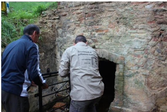
27. Prueba para la colocación de la reja de cierre en el acceso a Fuente Vieja
