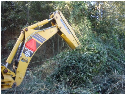
5. Retirada del zarzal por medios mecánicos
