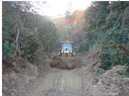
6. Apertura de acceso a la zona de Fuente Vieja por medios mecánicos
