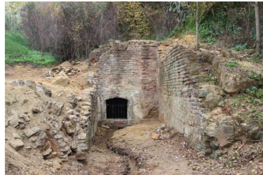
40. Aspecto de Fuente Vieja tras la limpieza
