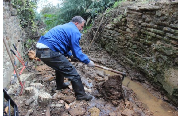
26. Primeros trabajos de limpieza en Fuente Vieja con el voluntariado
