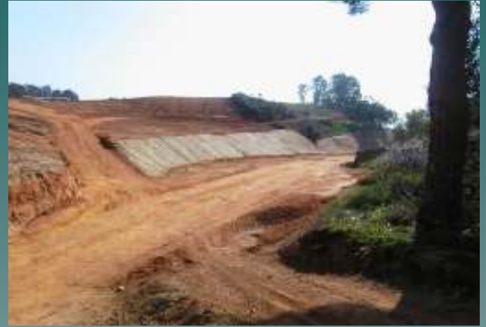
Las obras comenzaron siguiendo un diseño consensuado.
