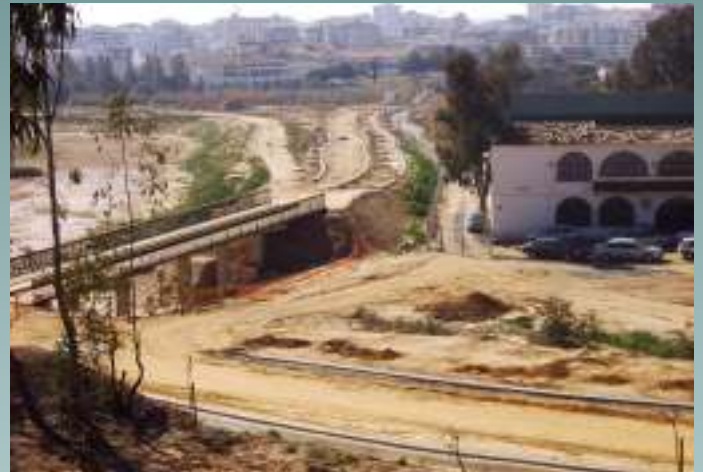
que resultó con demasiado hormigón.
